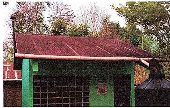
Foto 2: Cambio de laminas en mal estado de bodega. MODULO 1
